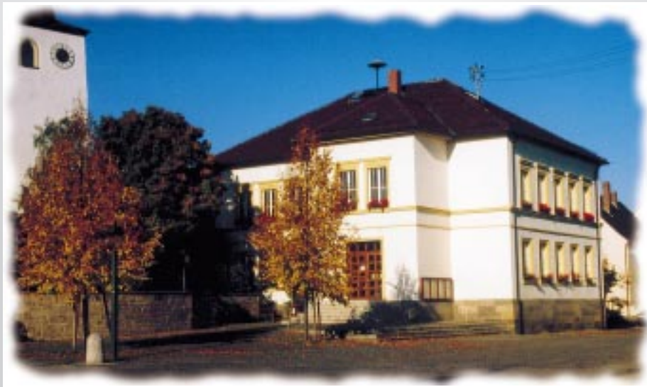
Rathaus der Gemeinde Schwebheim, Kirchplatz 2
