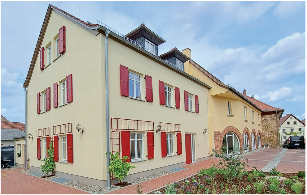
Bürgerhausanbau mit barrierefreier Außenstelle Rathaus und Mehrgenerationenhaus
